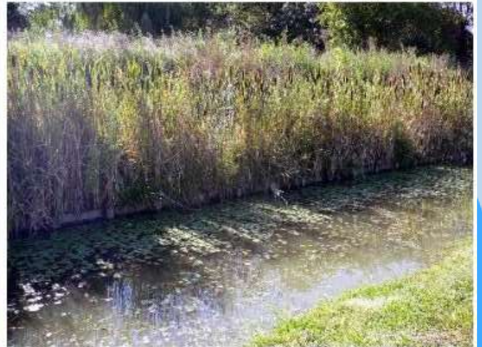
Berge stabilisée, Jardin de Borderouge
